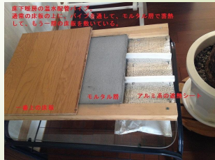
床下の白いチューブの配管で温水を回して、モルタル層で蓄熱している。
