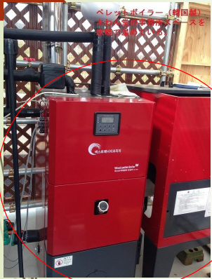
韓国製のペレットボイラー床暖房が、事務所床に導入されています。
