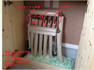
温水の循環スペースは、部屋ごとに開閉してコントロールできる。
