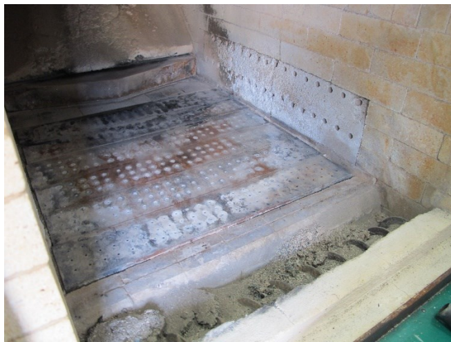
炉内 清掃後 手前スクリュウによる灰出し
