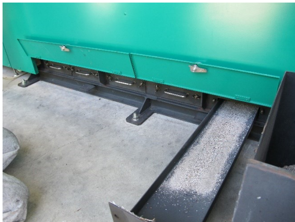
下部 灰出しパレットの清掃作業
